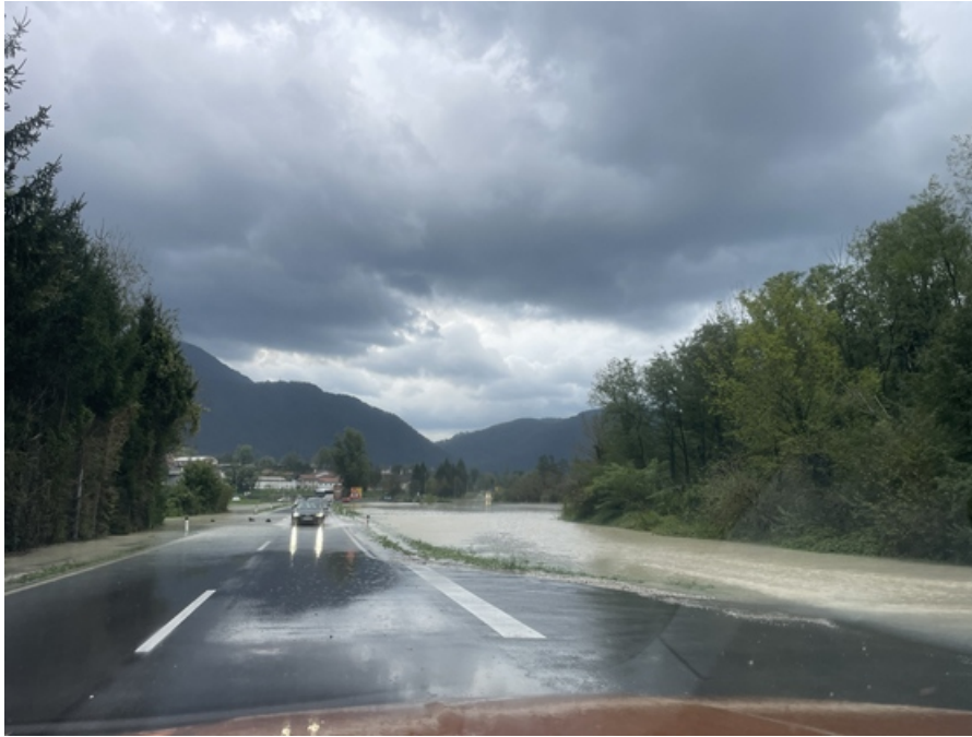
Slika 15: Poplavljena cesta pod kasarnami.
